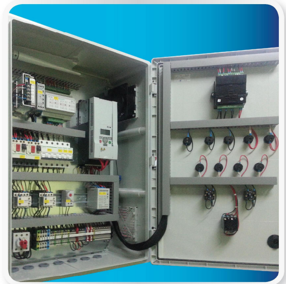
Przykład montażu aparatury sterowniczej i osprzętu
